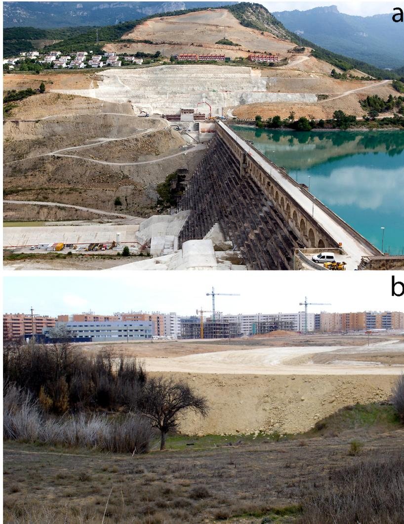
Figura 11: Proyectos constructivos que ignoran la geología del emplazamiento. (a) Ladera en la que se apoya el estribo derecho de la presa de Yesa, sujeta a una inestabilidad crónica. (b) Dolina en fase de relleno durante las obras de urbanización de Arcosur, en Zaragoza.
