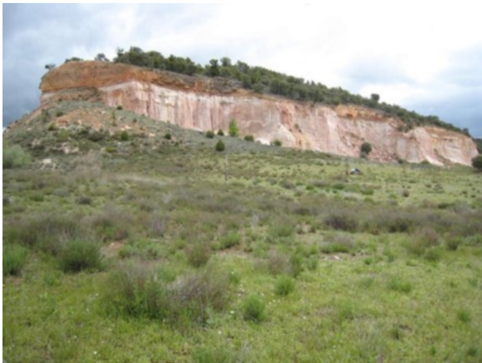
Figura 21: Vista de la ladera cóncava en la restauración de la cantera Revilla. Se trata de una forma de relieve estable que no ha limitado el desarrollo del suelo y la vegetación. No se incorporó una red de drenaje, lo que hubiera requerido un diseño en 3 dimensiones. Foto: J.M. Nicolau.
