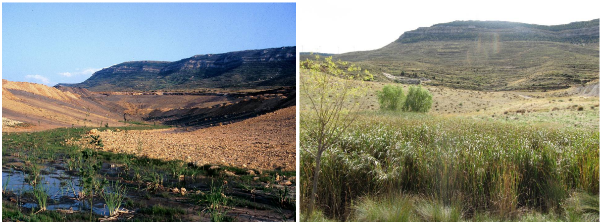
Figura 18: Restauración en cuenca hidrológica de la explotación minera Ampliación de Alemanes, por la empresa Minas y Ferrocarril de Utrillas (Utrillas, Teruel). La imagen de la izquierda muestra el proceso de conformación de la topografía, con apilamientos de tierra vegetal a la izquierda, listos para ser extendidos. La imagen de la derecha muestra la evolución 10 años después de su restauración. Foto izquierda: archivo MFU. Foto derecha: J.M. Nicolau.
