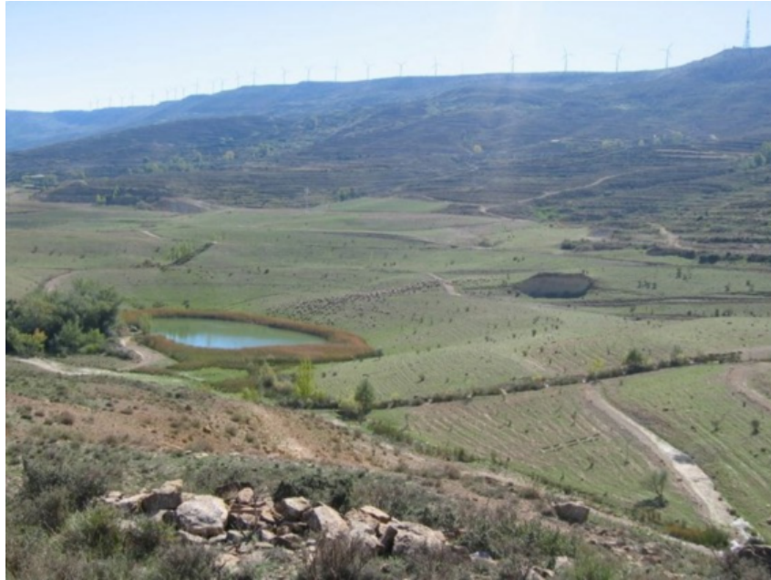
Figura 17: Restauración de la explotación minera Alemanes, por la empresa Minas y Ferrocarril de Utrillas (Utrillas, Teruel). El área restaurada se organiza en cuencas hidrológicas independientes; compuestas de laderas (todavía muy rectilíneas) y cauces de tipo cuneta, que drenan en el humedal que ocupa el hueco final. Éste vierte sus aguas a un barranco natural cuando rebosa. Fotografía: J.M. Nicolau.
